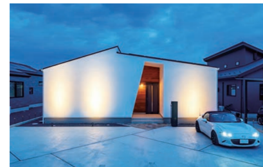
漆喰の塗り壁が映えるよう、夜になると美しくライトアップされる仕掛けに。エントランスの斜め壁や無垢の羽目板がさらにカッコ良さを引き立てている。
